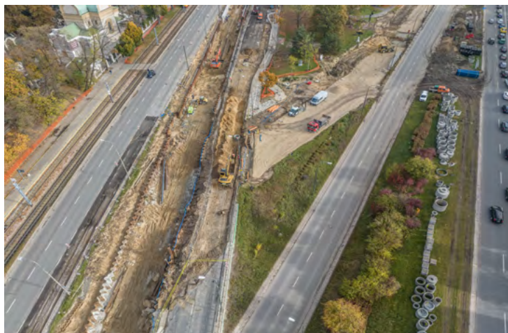
Fot. Prace realizowane na wysokości ul. Wolskiej i Kasprzaka
