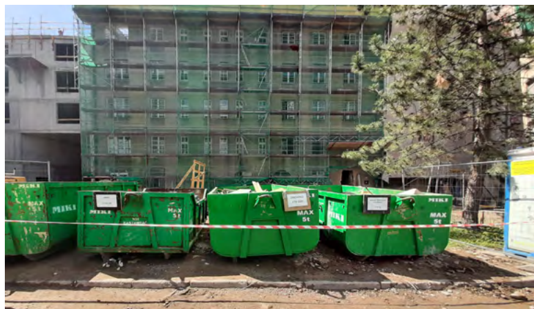
Fot. przykłady oznakowania miejsc składowania odpadów na budowie STRABAG
