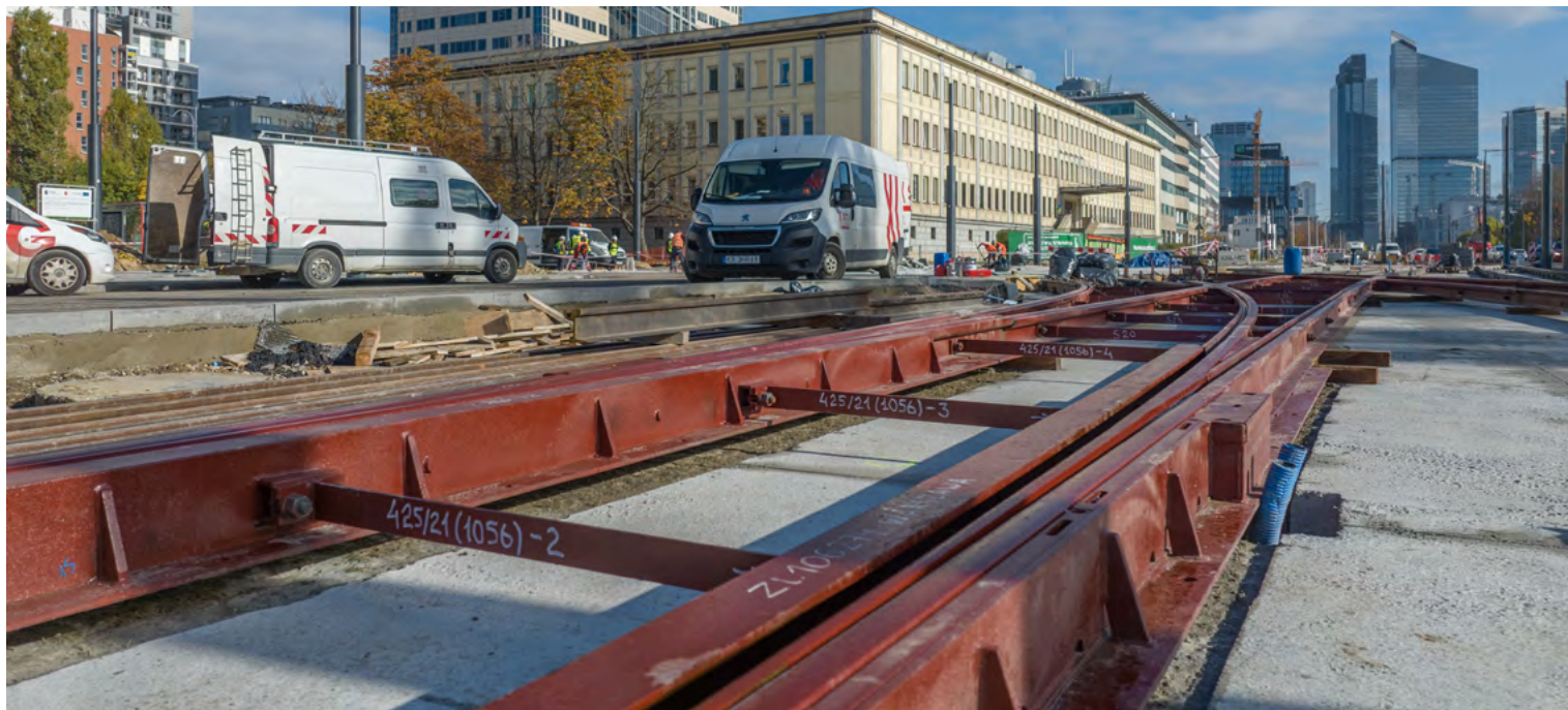
Fot. nowe torowisko w ciągu ul. Kasprzaka z rozjazdem w ul. Skierniewickiej
