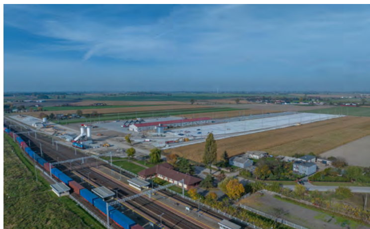
Fot. budowany terminal z bocznicą kolejową
