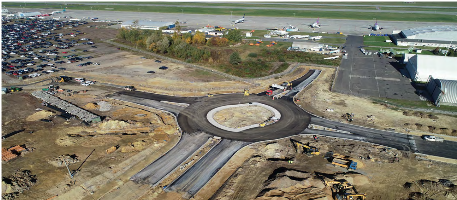
Fot. prace realizowane są w bezpośrednim sąsiedztwie lotniska
