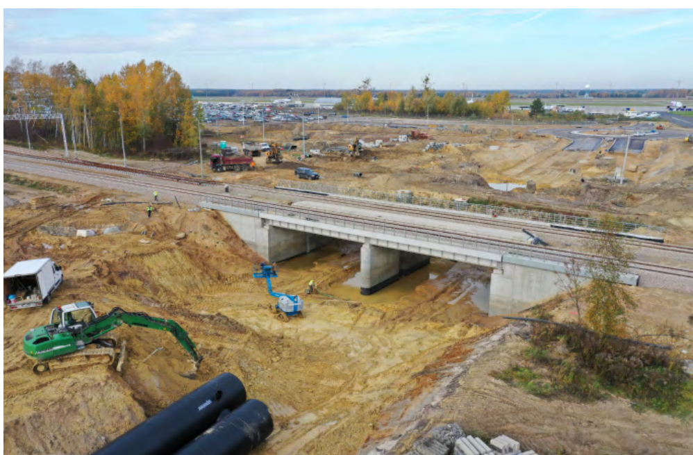
Fot. widok na realizowany odcinek DW 913, rondo bliżej lotniska oraz wykop pod wiaduktem kolejowym
